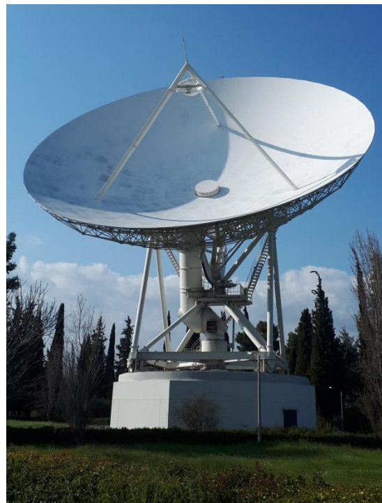
Εικόνα 1. Η υποδομή της κεραίας δορυφορικών τηλεπικοινωνιών του Ομίλου ΟΤΕ στο ΚΔΕΘ, που μετασχηματίζεται στο πρώτο Ελληνικό Ραδιοτηλεσκόπιο. Το όργανο είναι παραβολοειδούς τύπου με διαμέτρου 32 μέτρων και ονομάζεται THERMOρύλαε.
